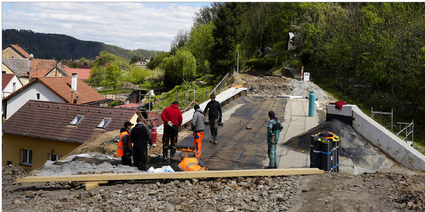
Během výstavby nového železničního mostu Na Důlích probíhá i rekonstrukce viaduktu v Růžové ulici. Foto: Kristýna Urbanová
