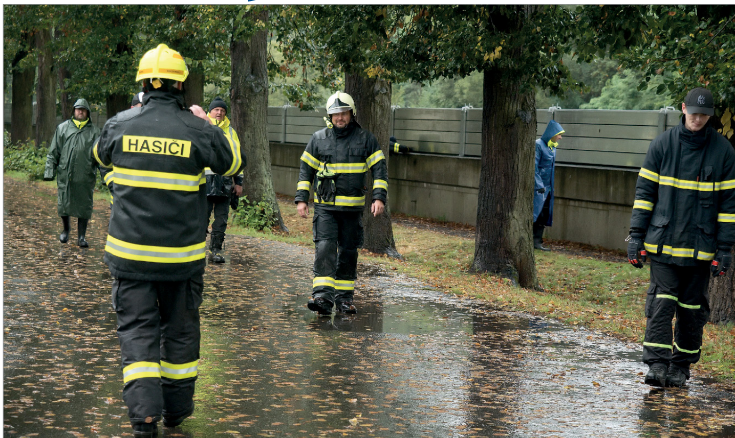
Hasiči při instalaci protipovodňové hráze. Foto: Radek Tupy
