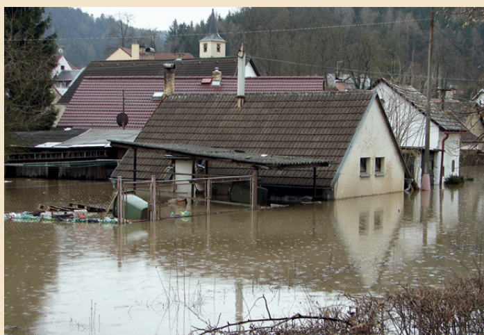
▲ Zaplavený Závrtok při povodni v roce 2006
