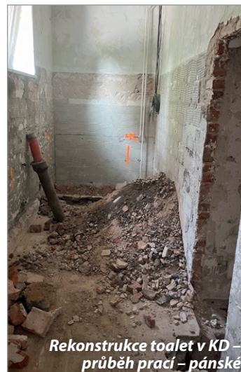
Rekonstrukce toalet v KD – průběh prací – dámské
